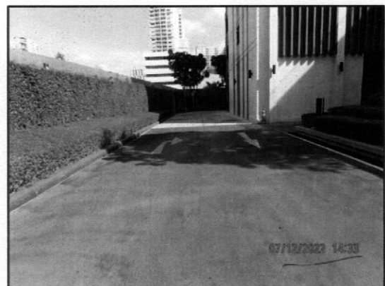
ถนนด้านขวาอาคาร
