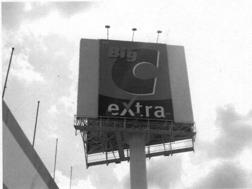
ภาพถ่ายโครงป้าย
