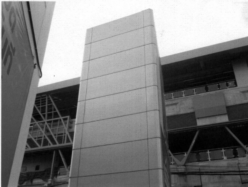
ภาพถ่ายโครงป้าย
