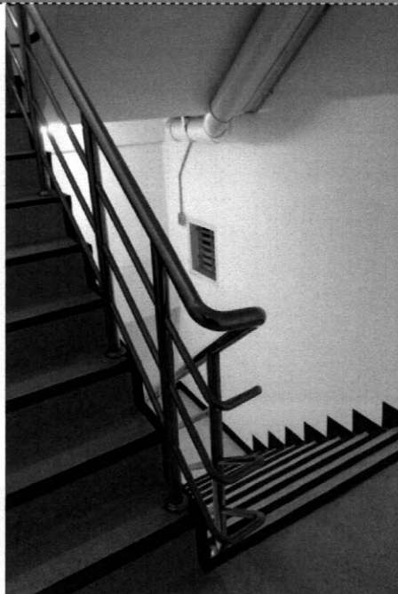
รูปแสดงลักษณะบันไดหนีไฟ
