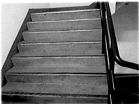
ชั้น 18 - บันไดหนีไฟ
