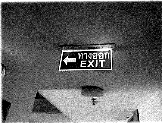
ชั้น 12 - ป้ายแสดงเส้นทางหนีไฟ
