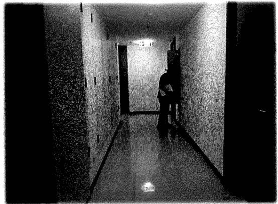
ชั้น 18 - โถงทางเดินภายในอาคาร
