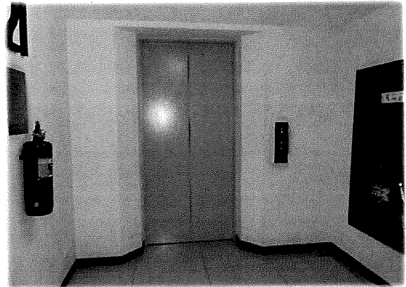
ชั้น 22 - ลิฟต์หนีไฟ
