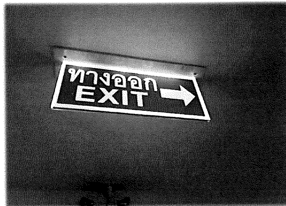
ชั้น 12 - ป้ายแสดงเส้นทางหนีไฟ
