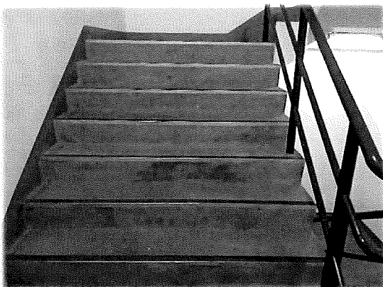
ชั้น 22 - บันไดหนีไฟ
