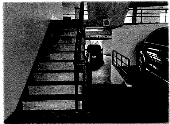
ชั้น 3 - บันไดหนีไฟ ภายในลานจอดรถ
