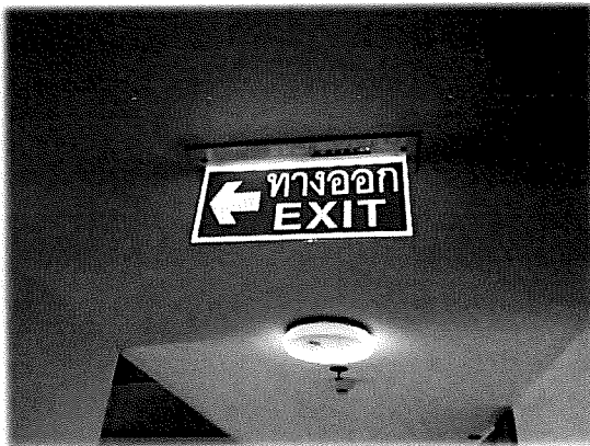
ชั้น 18 - ป้ายแสดงเส้นทางหนีไฟ
