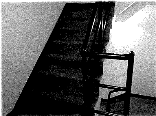
ชั้น 18 - บันไดหนีไฟ
