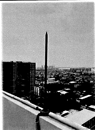
ชั้นดาดฟ้า - ระบบป้องกันฟ้าผ่า
