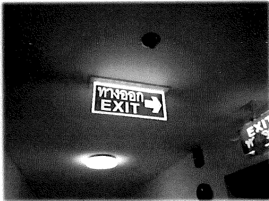
ชั้น 22 - ป้ายแสดงเส้นทางหนีไฟ
