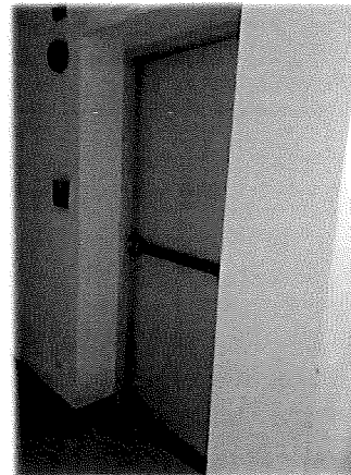
ชั้น 22 - ประตูหนีไฟ
