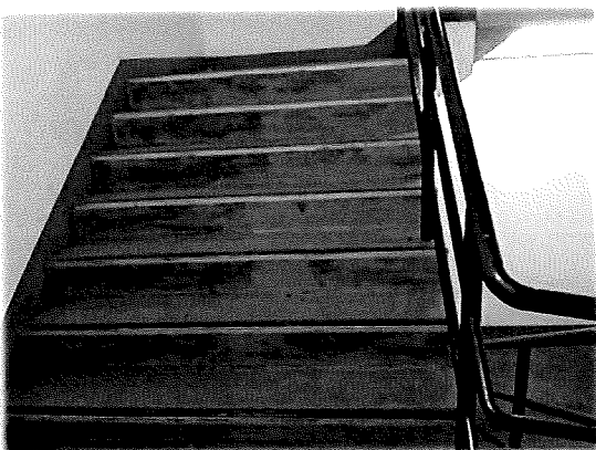
ชั้น 12 - บันไดหนีไฟ
