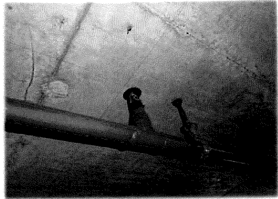
ชั้น 3 - สปริงเกอร์
