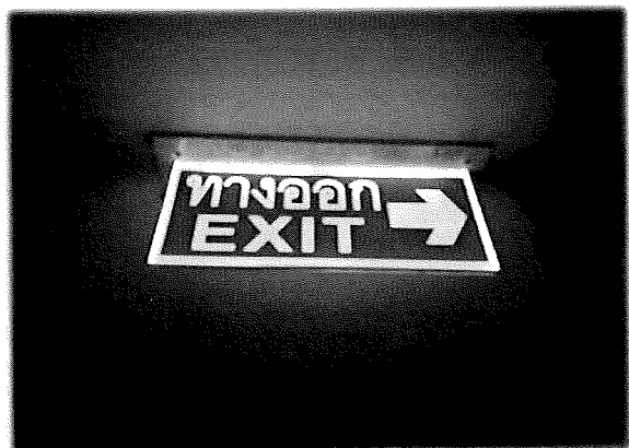
ชั้น 22 - ป้ายแสดงเส้นทางหนีไฟ
