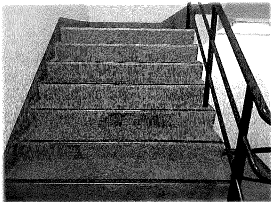
ชั้น 22 - บันไดหนีไฟ
