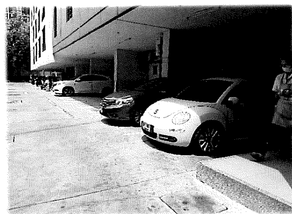
ลานจอดรถภายนอกอาคาร
