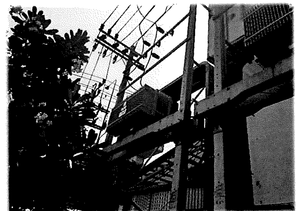
หม้อแปลงไฟฟ้า
