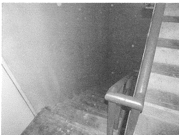
11. ภายในบันไดหนีไฟ
