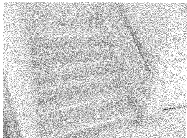
10. ภายในบันไดหนีไฟ
