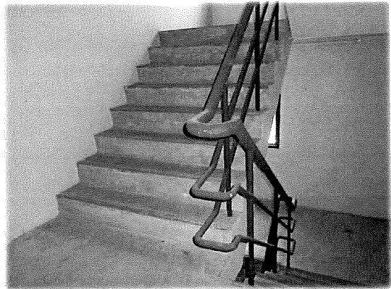
ชั้น 5 - บันไดหนีไฟ
