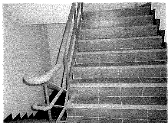
ชั้น 5 - บันไดหนีไฟ
