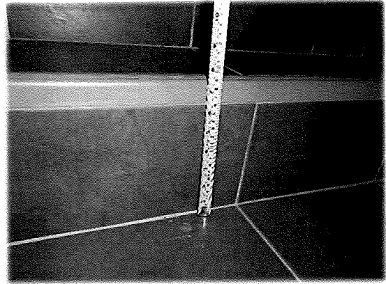
ชั้น 2 - บันไดหนีไฟ
