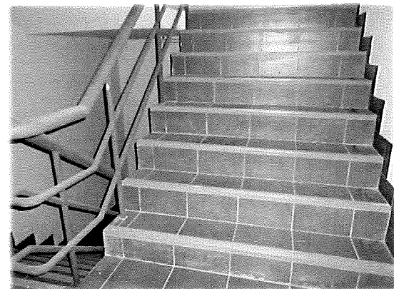
ชั้น 2 - บันไดหนีไฟ
