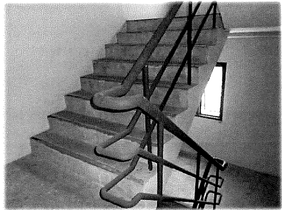
ชั้น 7 - บันไดหนีไฟ
