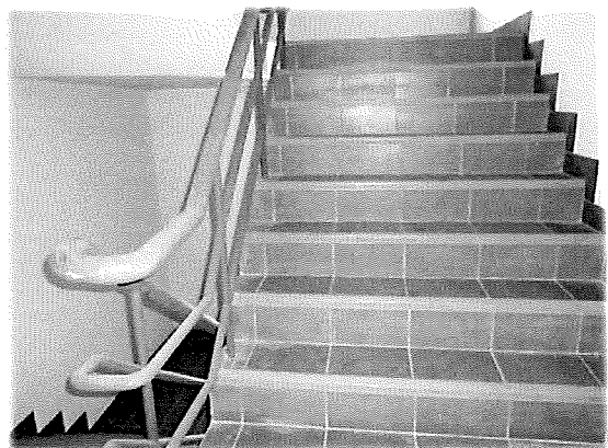
ชั้น 7 - บันไดหนีไฟ
