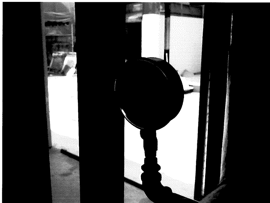
ภาพการทดสอบระบบสูบน้ำดับเพลิง
