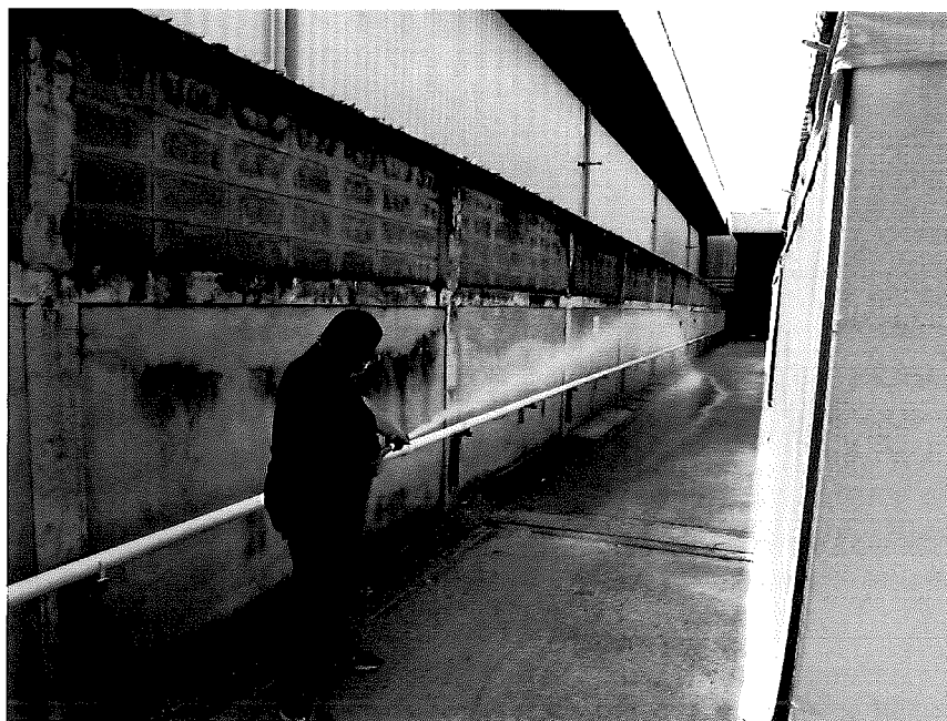
ภาพการทดสอบการฉีดน้ำดับเพลิง
