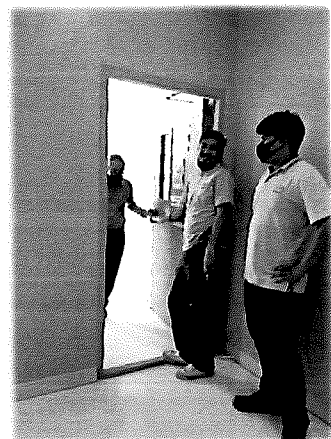
ชั้น 3 - ประตูหนีไฟ
