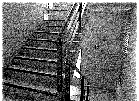
ชั้น 2 - บันไดหนีไฟ
