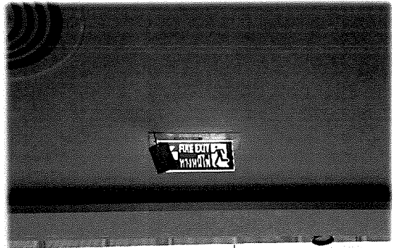
ชั้น 3 - ป้ายแสดงเส้นทางหนีไฟ
