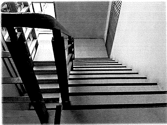
ชั้น 3 - บันไดหนีไฟ
