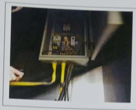
อุปกรณ์ควบคุมไฟฟ้าแสงสว่างสำหรับป้าย
