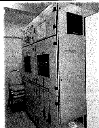
ตู้ควบคุมกระแสไฟฟ้าหลัก
