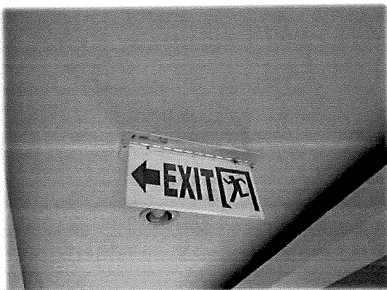
ชั้น 6 - ป้ายแสดงเส้นทางหนีไฟ
