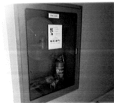
ชั้น 4 - ตู้ดับเพลิงและสายฉีดน้ำดับเพลิง
