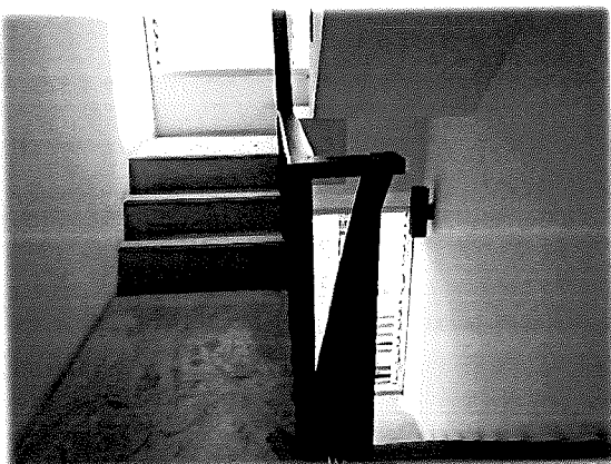
ชั้น 4 - บันไดหนีไฟ
