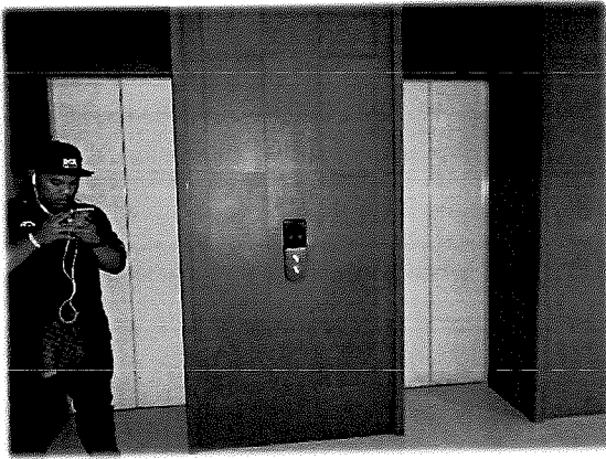
ชั้น 4 - โถงน้ำลิฟต์
