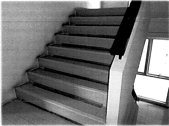
ชั้น 4 - บันไดหนีไฟ
