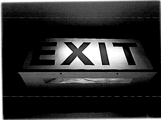
ชั้น 1 - บ้ายแสดงเส้นทางหนีไฟ
