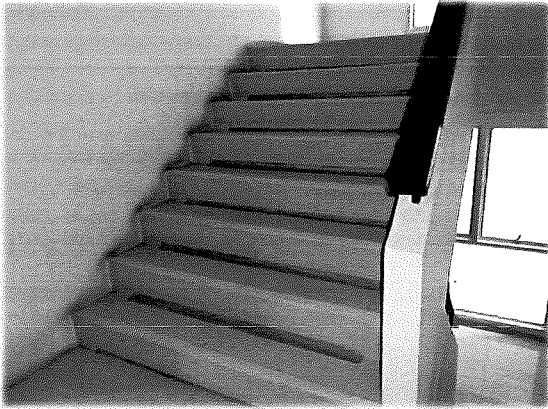
ชั้น 6 - บันไดหนีไฟ
