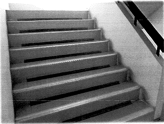
ชั้น 8 - บันไดหนีไฟ
