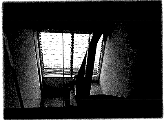
ชั้น 8 - บันไดหนีไฟ
