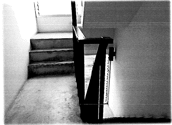
ชั้น 6 - บันไดหนีไฟ
