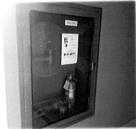
ชั้น 8 - ตู้ดับเพลิงและสายฉีดน้ำดับเพลิง
