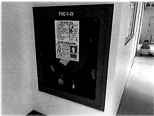
ชั้น 1 - ตู้ดับเพลิงและสายฉีดน้ำดับเพลิง
