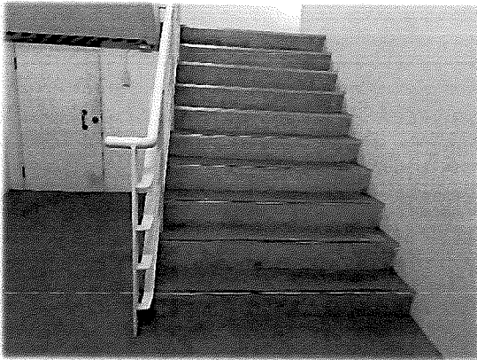
ชั้น 1 - บันไดหนีไฟ
