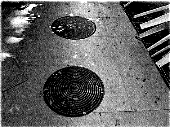
บ่อบำบัดน้ำเสีย
