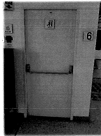
ชั้น 6 - ประตูหนีไฟ
