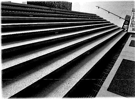
ชั้นใต้ดิน - บันไดขึ้น-ลงชั้นใต้ดิน
