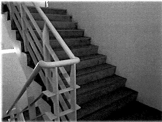
ชั้น 4 - บันไดหนีไฟ
