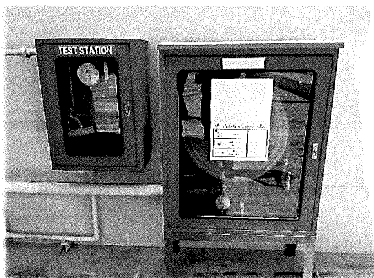
ชั้นดาดฟ้า - ตู้ดับเพลิงและสายฉีดน้ำดับเพลิง
