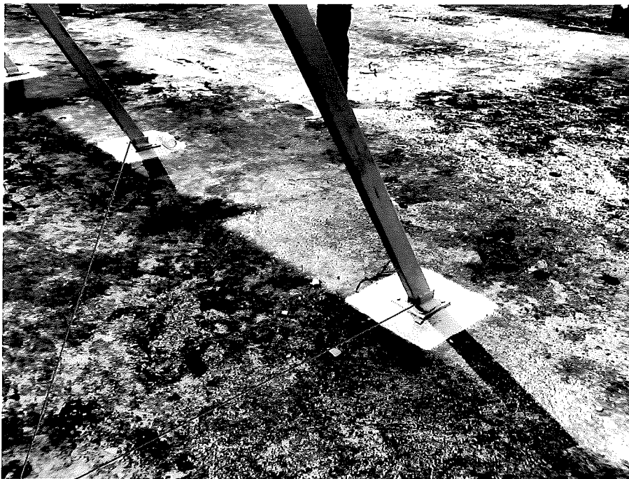
PLATE เหล็กโยงยึดเสาเหล็กค้ำยันด้านหลังมีความมั่นคงแข็งแรง
