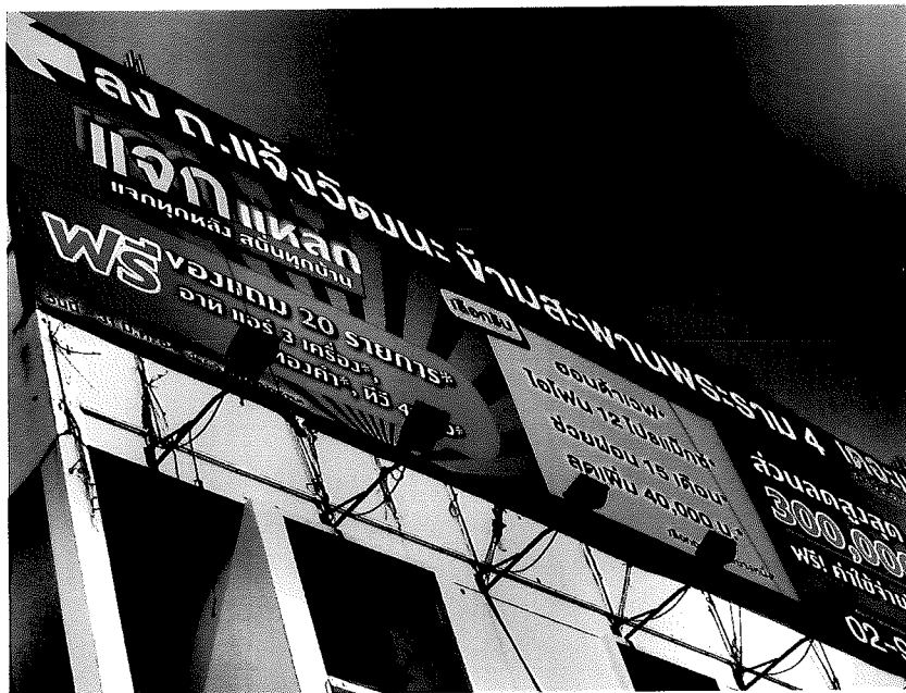
ขาลอดไฟสามารถใช้งานได้
