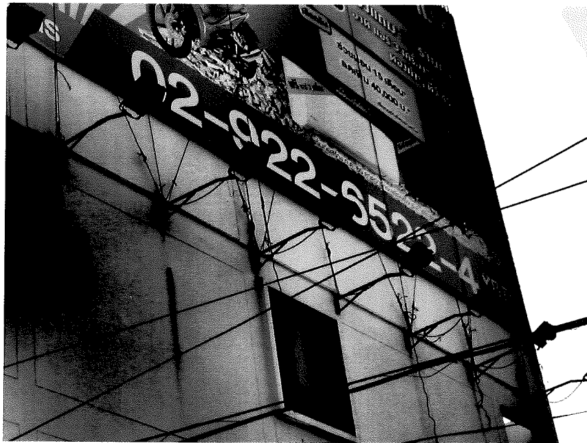
ขาดไฟและอุปกรณ์ไฟฟ้าสามารถใช้งานได้
