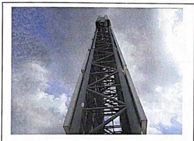
โครงสร้างเสาและการจับยึดของตัวป้าย
