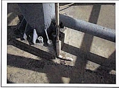
โครงสร้างรากฐานและการจับยึดของโครงเสาป้าย
