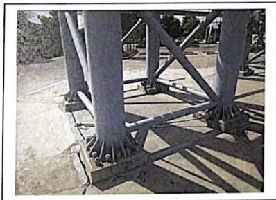
โครงสร้างรากฐานและการจับยึดของโครงเสาป้าย
