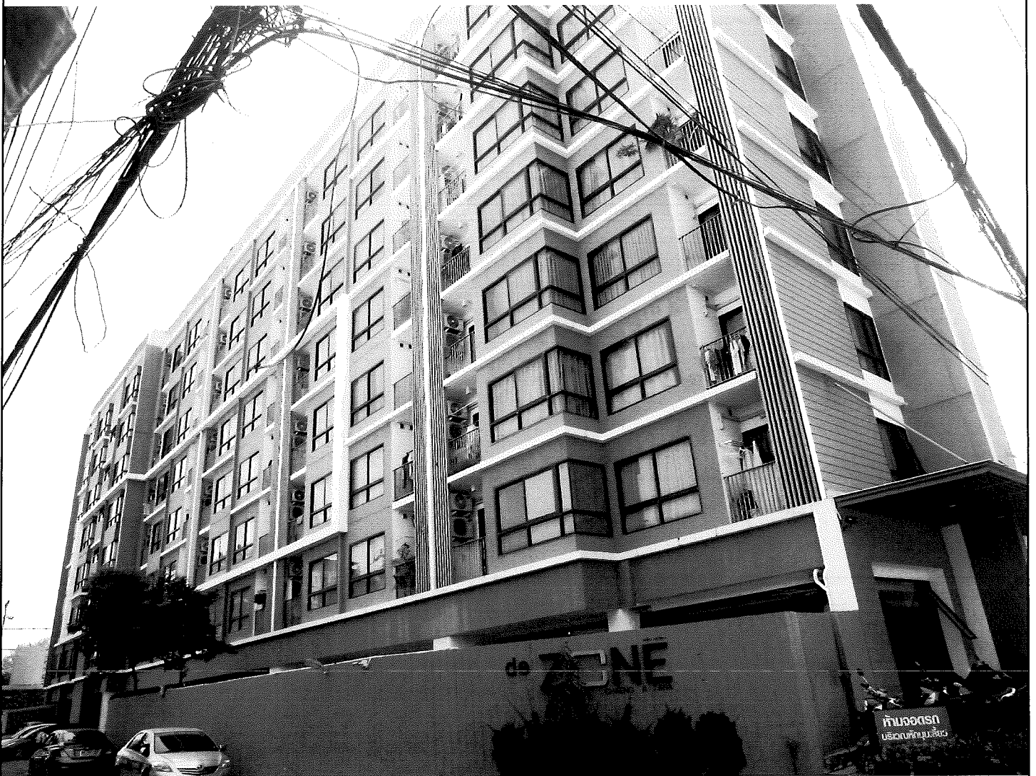
รูปภาพอาคาร เดอะ โซน แจ้งวัฒนะ 23 ตรวจสอบอาคาร เดือน ธันวาคม 2563
