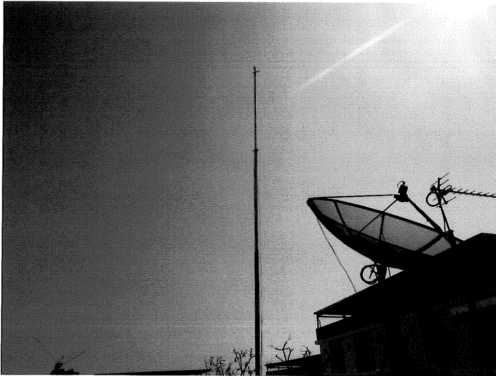
ภาพระบบป้องกันฟ้าผ่า มีการดูแลและตรวจสอบเบื้องต้นจากทางฝ่ายอาคาร
