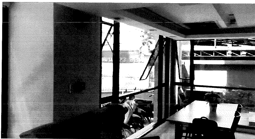
ภาพการทดสอบระบบสัญญาณแจ้งเหตุเพลิงไหม้
