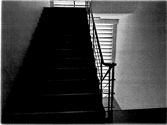
ชั้น 16 - บันไดหนีไฟ
