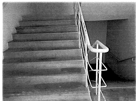
ชั้น 8 - บันไดหนีไฟ
