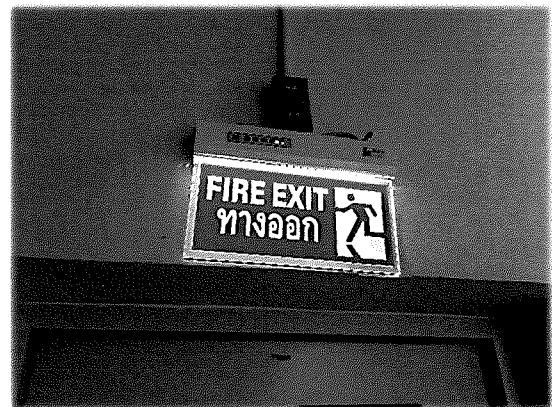
ชั้น 16 - ป้ายแสดงเส้นทางหนีไฟ
