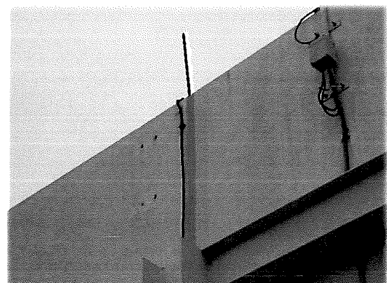
ชั้นดาดฟ้า - ระบบป้องกันฟ้าผ่า
