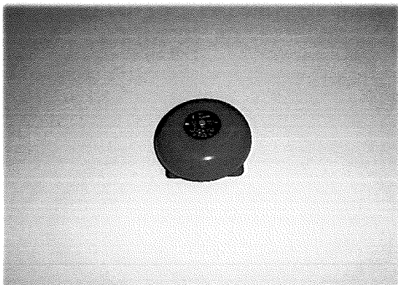
ชั้น 3 - สัญญาณแจ้งเหตุเพลิงไหม้
