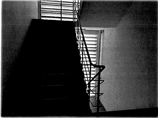
ชั้น 8 - บันไดหนีไฟ
