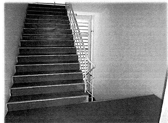
ชั้น 3 - บันไดหนีไฟ
