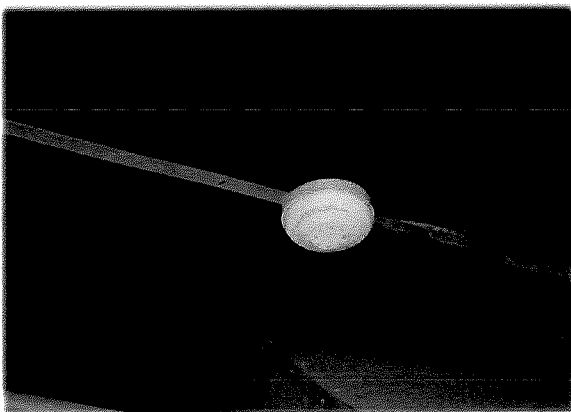
ชั้น M2 - อุปกรณ์ตรวจจับควัน
