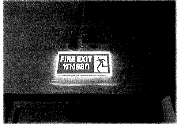
ชั้น 3 - ป้ายแสดงเส้นทางหนีไฟ
