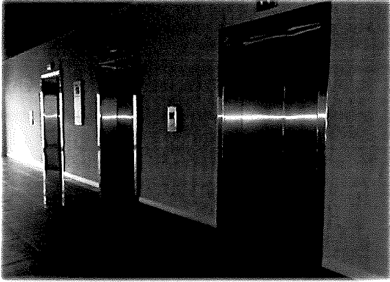
ชั้น 16 - โถงน้ำลิฟต์
