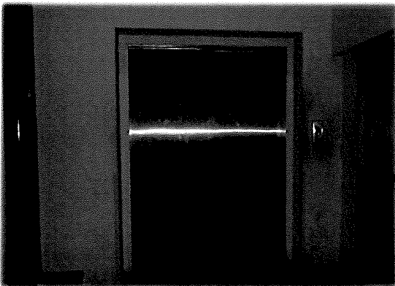
ชั้น 3 - ลิฟต์หนีไฟ
