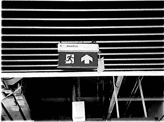
ชั้น 8 - บ้ายแสดงเส้นทางหนีไฟ
