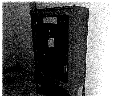
ชั้นดาดฟ้า - ตู้ดับเพลิงและสายฉีดน้ำดับเพลิง
