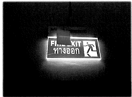
ชั้น 3 - ป้ายแสดงเส้นทางหนีไฟ
