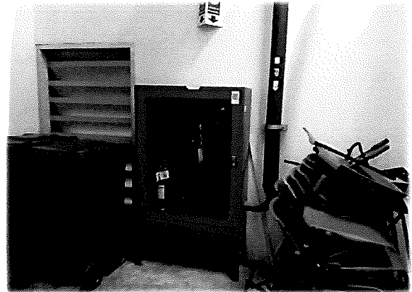
ชั้น 3 - ตู้ดับเพลิงและสายฉีดน้ำดับเพลิง
