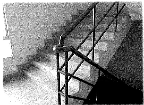
ชั้น 6 - บันไดหนีไฟ
