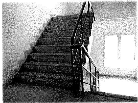
ชั้น 6 - บันไดหนีไฟ
