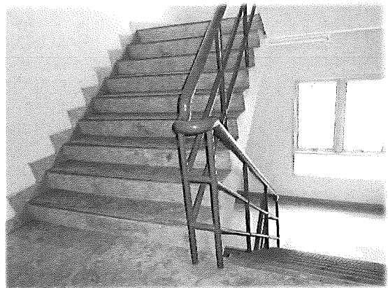
ชั้น 4 - บันไดหนีไฟ
