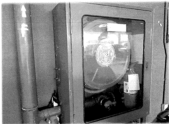
ตู้ดับเพลิงและสายฉีดน้ำดับเพลิง
