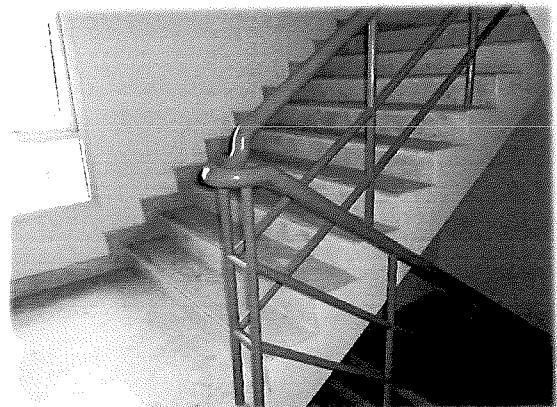
ชั้น 4 - บันไดหนีไฟ
