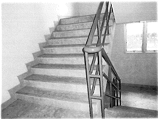
ชั้น 2 - บันไดหนีไฟ
