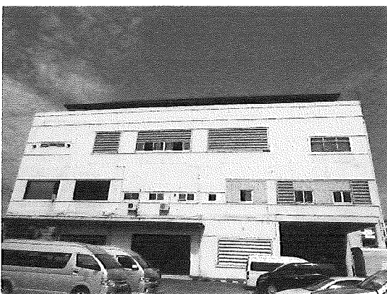
5. โครงสร้างอาคารด้านหลัง
