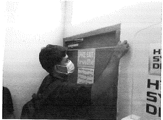
38. ตรวจสอบประตูหนีไฟ
