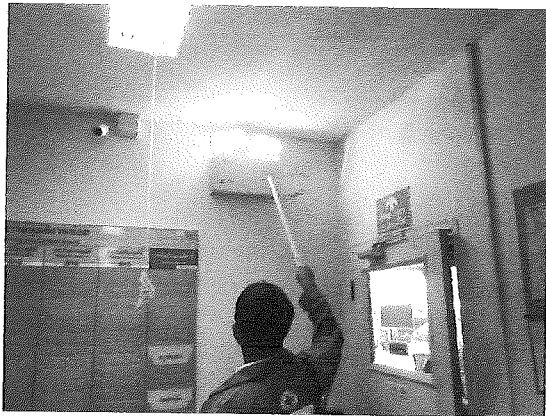
39. ทดสอบไฟฉุกเฉิน
