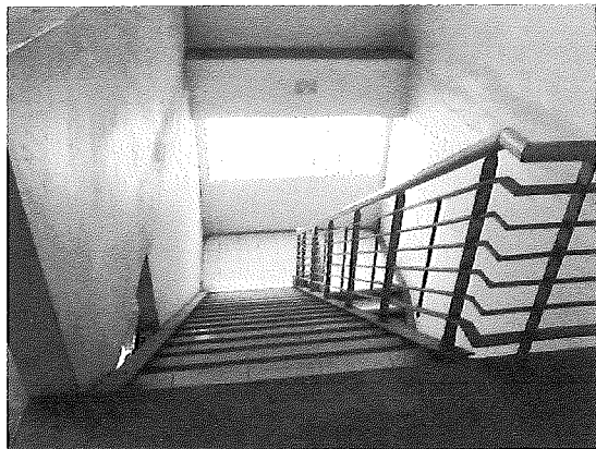
21. บันไดหนีไฟ
