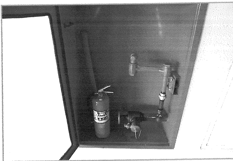
การติดตั้งถังดับเพลิงและตู้หัวฉีดน้ำดับเพลิง
