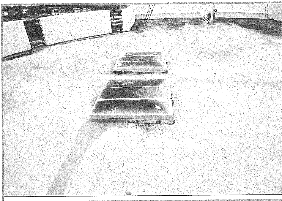
ถังเก็บน้ำใต้ชั้นดาดฟ้า
