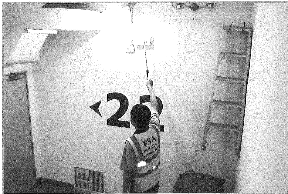
ระบบไฟส่องสว่างสำรอง
