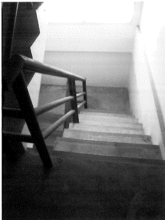
รูปที่ 1.1-15 แสดงภาพสภาพอาคารทั่วไป
