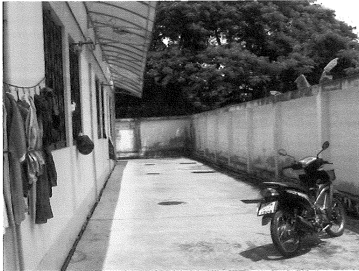
รูปที่ 1.1-07 แสดงภาพสภาพอาคารทั่วไป
