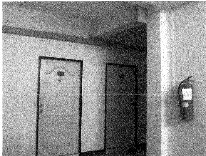
รูปที่ 1.1-13 แสดงภาพสภาพอาคารทั่วไป
