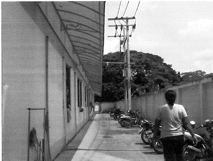
รูปที่ 1.1-03 แสดงภาพสภาพอาคารทั่วไป
