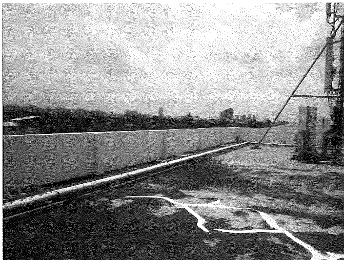
รูปที่ 1.1-09 แสดงภาพสภาพอาคารทั่วไป
