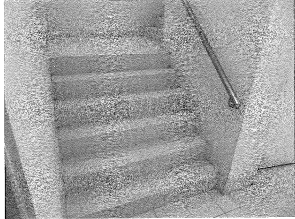
10. ภายในบันไดหนีไฟ
