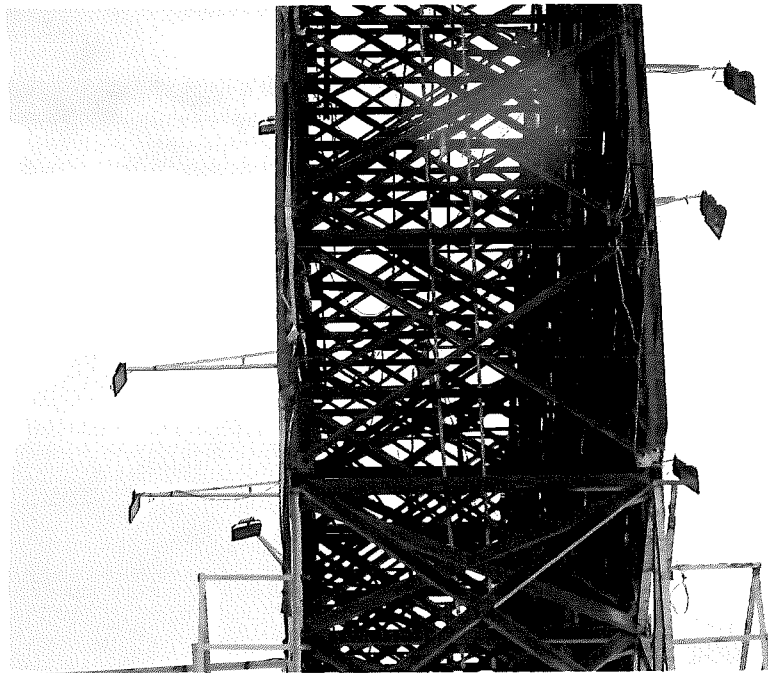
โครง TRUSS มีความมั่นคงแข็งแรง
