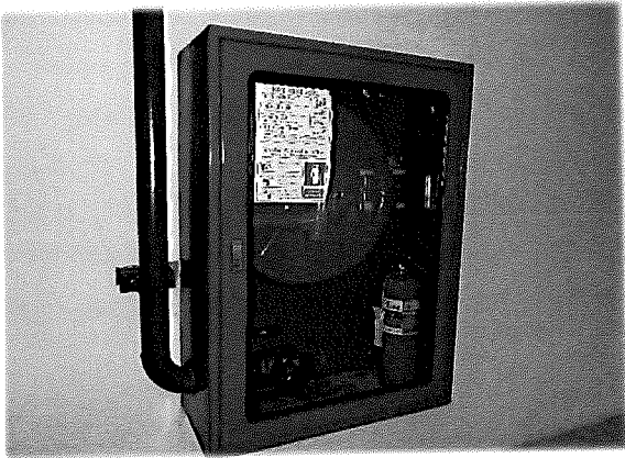
ชั้น 4 - ตู้ดับเพลิงและสายฉีดน้ำดับเพลิง
