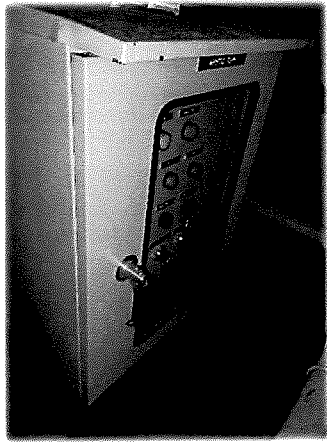
ชั้นดาดฟ้า - ตู้ควบคุมปั๊มเพิ่มแรงดันน้ำ
