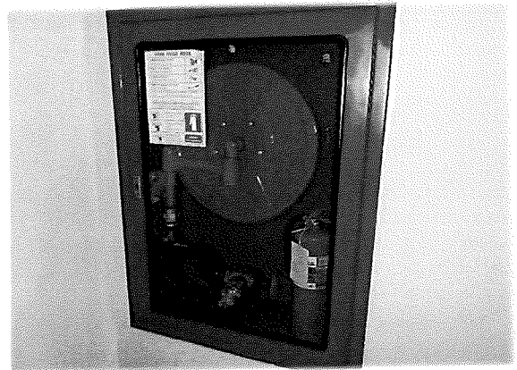
ชั้น 5 - ตู้ดับเพลิงและสายฉีดน้ำดับเพลิง
