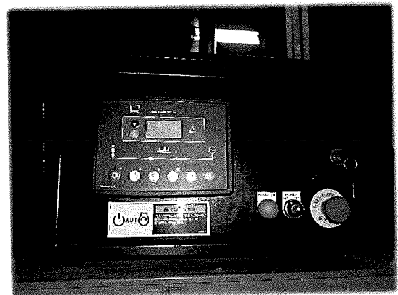
ตู้ควบคุมเครื่องกำเนิดไฟฟ้าสำรอง
