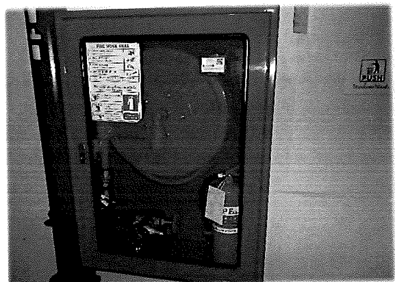
ชั้น 15 - ตู้ดับเพลิงและสายฉีดน้ำดับเพลิง
