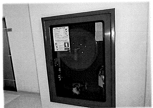
ชั้น 35 - ตู้ดับเพลิงและสายฉีดน้ำดับเพลิง
