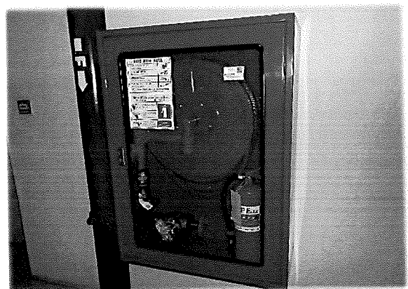
ชั้น 25 - ตู้ดับเพลิงและสายฉีดน้ำดับเพลิง
