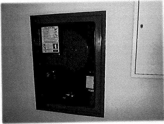
ชั้น 15 - ตู้ดับเพลิงและสายฉีดน้ำดับเพลิง
