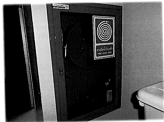
ชั้น 8 - ตู้ดับเพลิงและสายฉีดน้ำดับเพลิง
