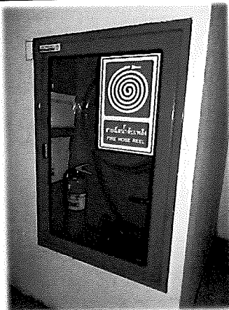
ชั้น B2 - ตู้ดับเพลิงและสายฉีดน้ำดับเพลิง
