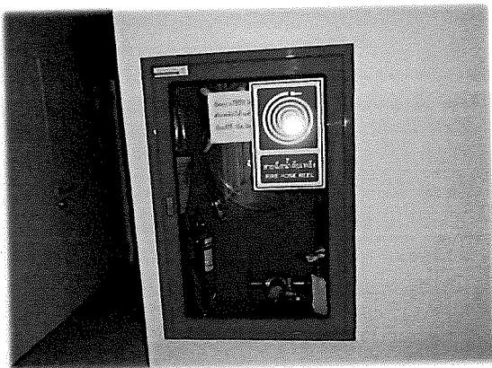
ชั้น 17 - ตู้ดับเพลิงและสายฉีดน้ำดับเพลิง
