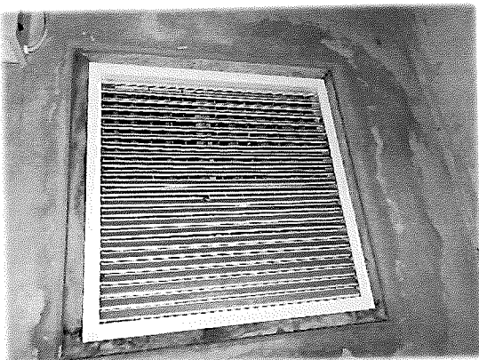
ชั้น 2 - ช่องพัดลมอัดอากาศ
