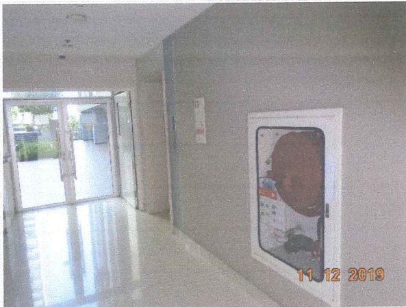
การตรวจสอบสภาพบริเวณโถงลิฟต์ เช่น ระบบเรียกลิฟต์ และโทรศัพท์ฉุกเฉิน
