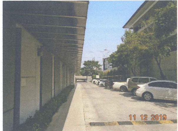
การตรวจสอบสภาพถนนเข้า-ออก อาคาร
