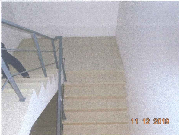
การตรวจสอบสภาพภายในบันไดหนีไฟ
