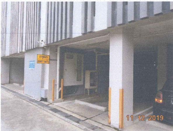
การตรวจสอบสภาพระบบระบายน้ำบริเวณอาคาร
