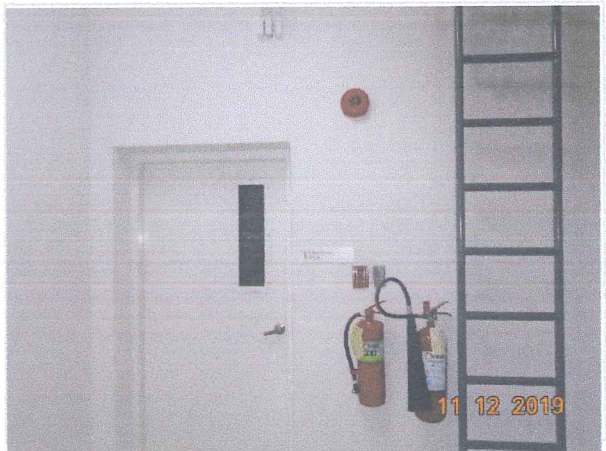
การตรวจสอบสภาพประตูหนีไฟและถังดับเพลิงมือถือ
