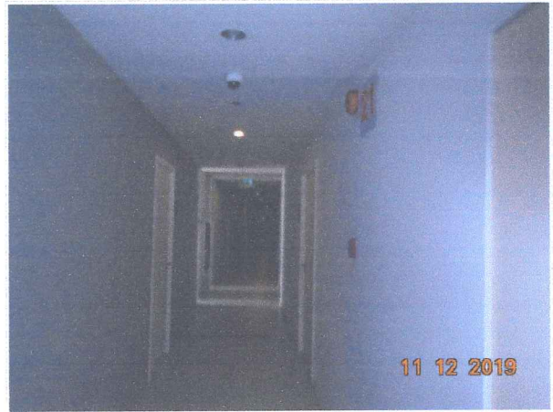
การตรวจสอบสภาพระบบแจ้งเหตุเพลิงไหม้ชนิดอัตโนมัติ
