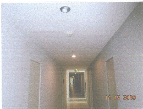
การตรวจสอบสภาพดวงโคมและการเดินสายไฟฟ้าภายในอาคาร
