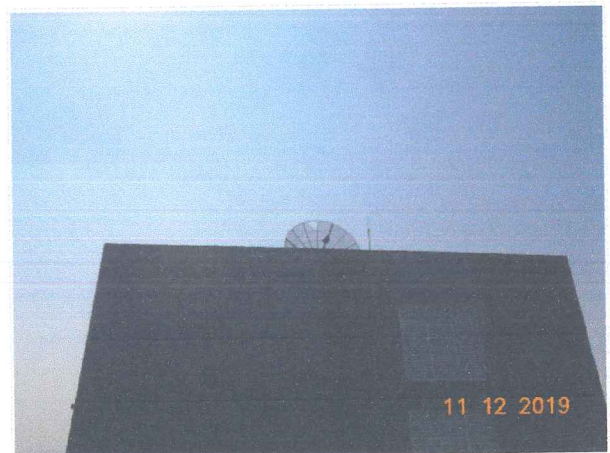
การตรวจสอบสภาพระบบล่อฟ้าอาคาร
