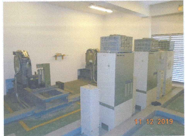
การตรวจสอบสภาพห้องควบคุมระบบขับเคลื่อนลิฟต์
