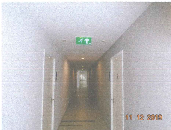
การตรวจสอบสภาพป้ายบอกทางหนีไฟ
