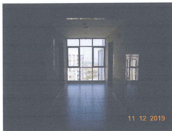
การตรวจสอบสภาพหน้าโถงลิฟต์ดับเพลิง
