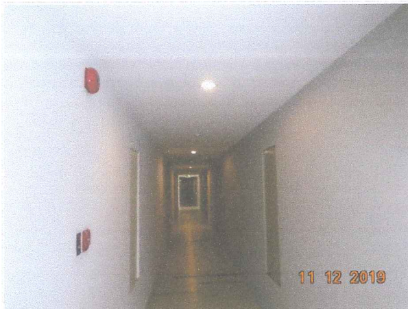
การตรวจสอบสภาพอุปกรณ์แจ้งเหตุเพลิงไหม้
