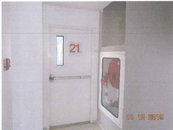
การตรวจสอบสภาพตู้สายฉีดน้ำดับเพลิง ถังดับเพลิงมือถือ และป้ายบอกขึ้น
