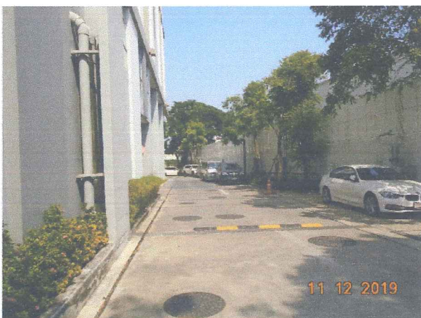
การตรวจสอบสภาพระบบบำบัดสิ่งปฏิกูลของอาคาร
