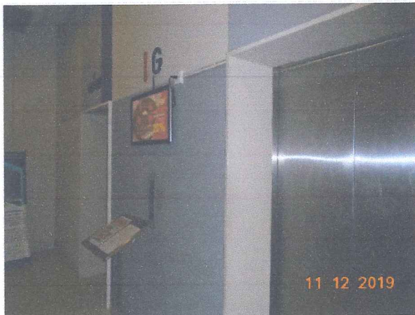
การตรวจสอบสภาพหน้าโถงลิฟต์โดยสาร
