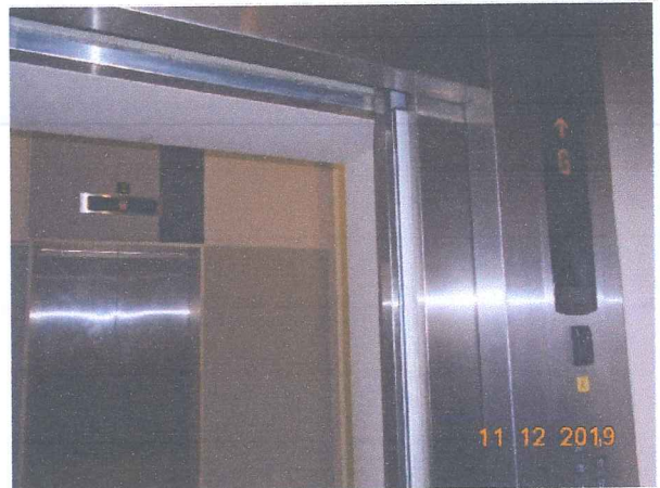
การตรวจสอบสภาพระบบควบคุมภายในลิฟต์โดยสาร
