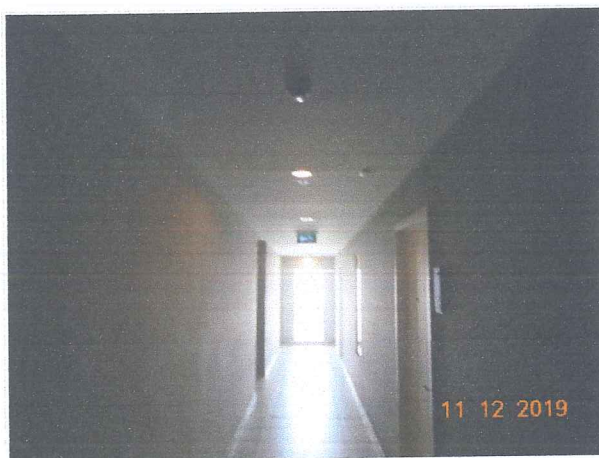
การตรวจสอบสภาพดวงโคมภายในอาคาร
