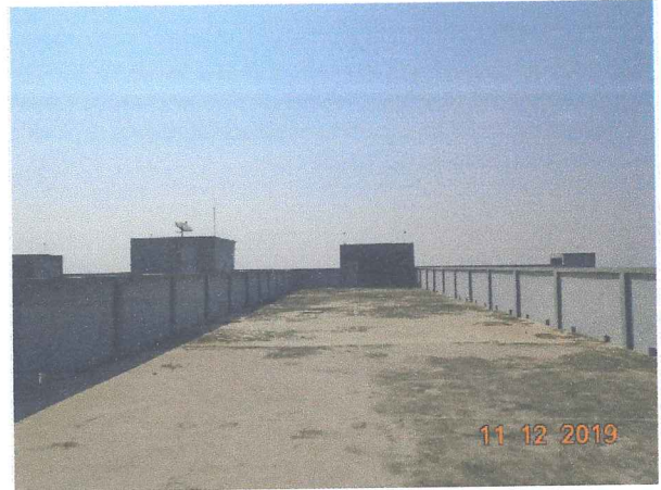
การตรวจสอบสภาพดาดฟ้าอาคาร
