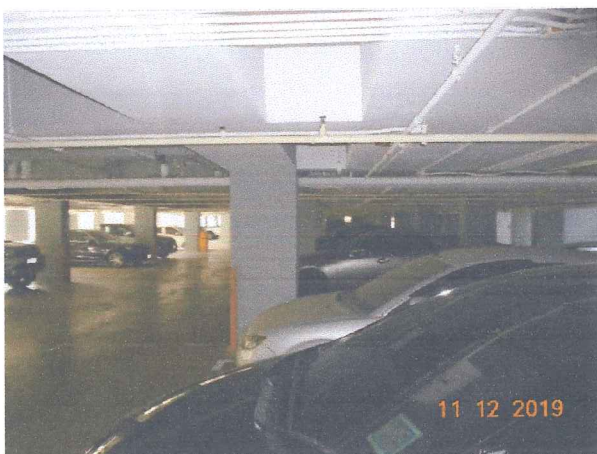
การตรวจสอบสภาพระบบดับเพลิงอัตโนมัติ
