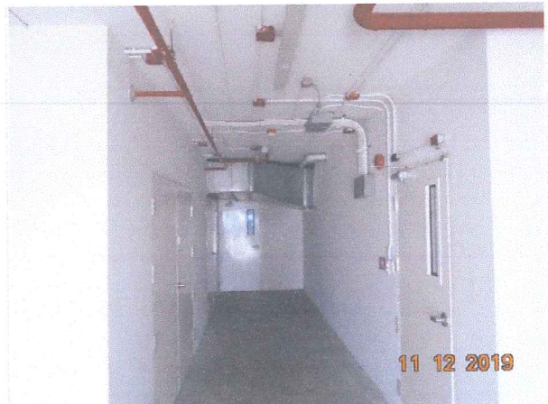
การตรวจสอบสภาพระบบป้องกันและระงับอัคคีภัย
