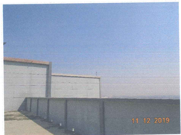
การตรวจสอบสภาพระบบหล่อฟ้าอาคาร
