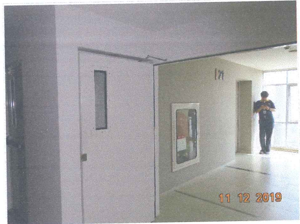
การตรวจสอบสภาพบริเวณโถงลิฟต์ดับเพลิง
