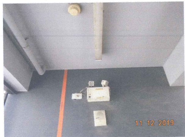
การตรวจสอบสภาพไฟแสงสว่างฉุกเฉิน
