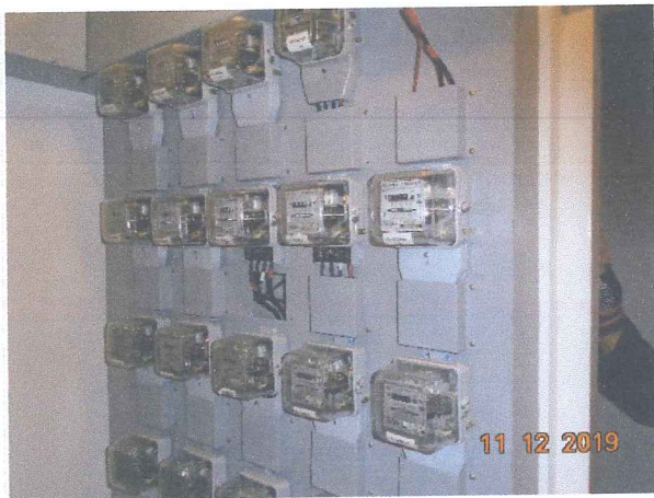
การตรวจสอบสภาพมิเตอร์ไฟฟ้าภายในอาคาร
