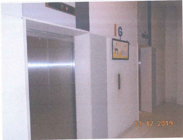
การตรวจสอบสภาพบริเวณโถงลิฟต์ เช่น ระบบเรียกลิฟต์ และโทรศัพท์ฉุกเฉิน
