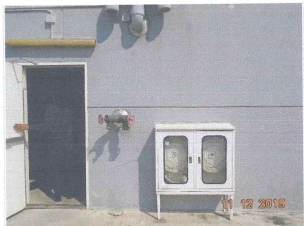
การตรวจสอบสภาพหัวรับน้ำดับเพลิงภายนอกอาคาร
