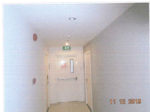
การตรวจสอบสภาพประตูหนีไฟ
