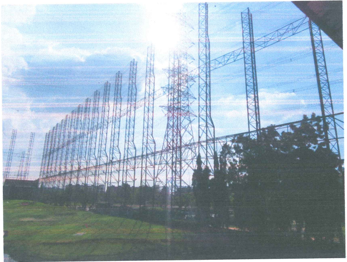
โครงเหล็กบริเวณสนามไดร์ฟกอล์ฟจากการตรวจด้วยสายตามีความมั่นคงแข็งแรง
