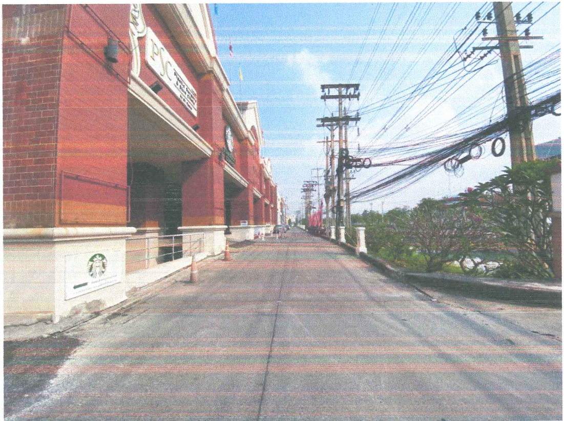
ถนนให้รถดับเพลิงสามารถเข้าไปถึงตัวอาคารและออกจากตัวอาคารได้โดยสะดวก
