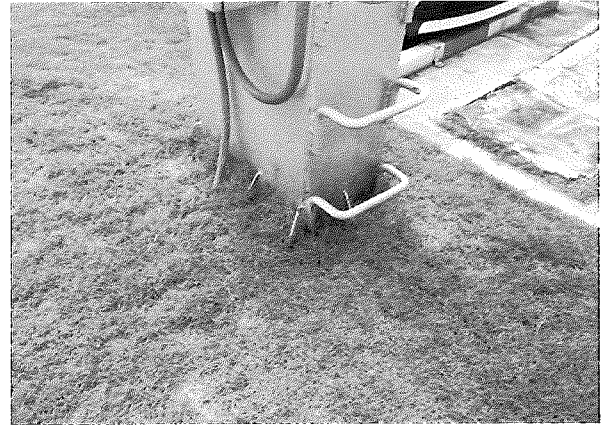
ฐานเสาป้าย
