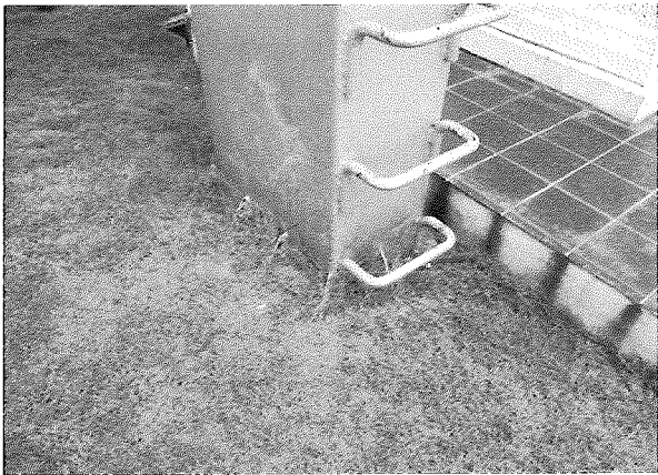
ฐานเสาป้าย
