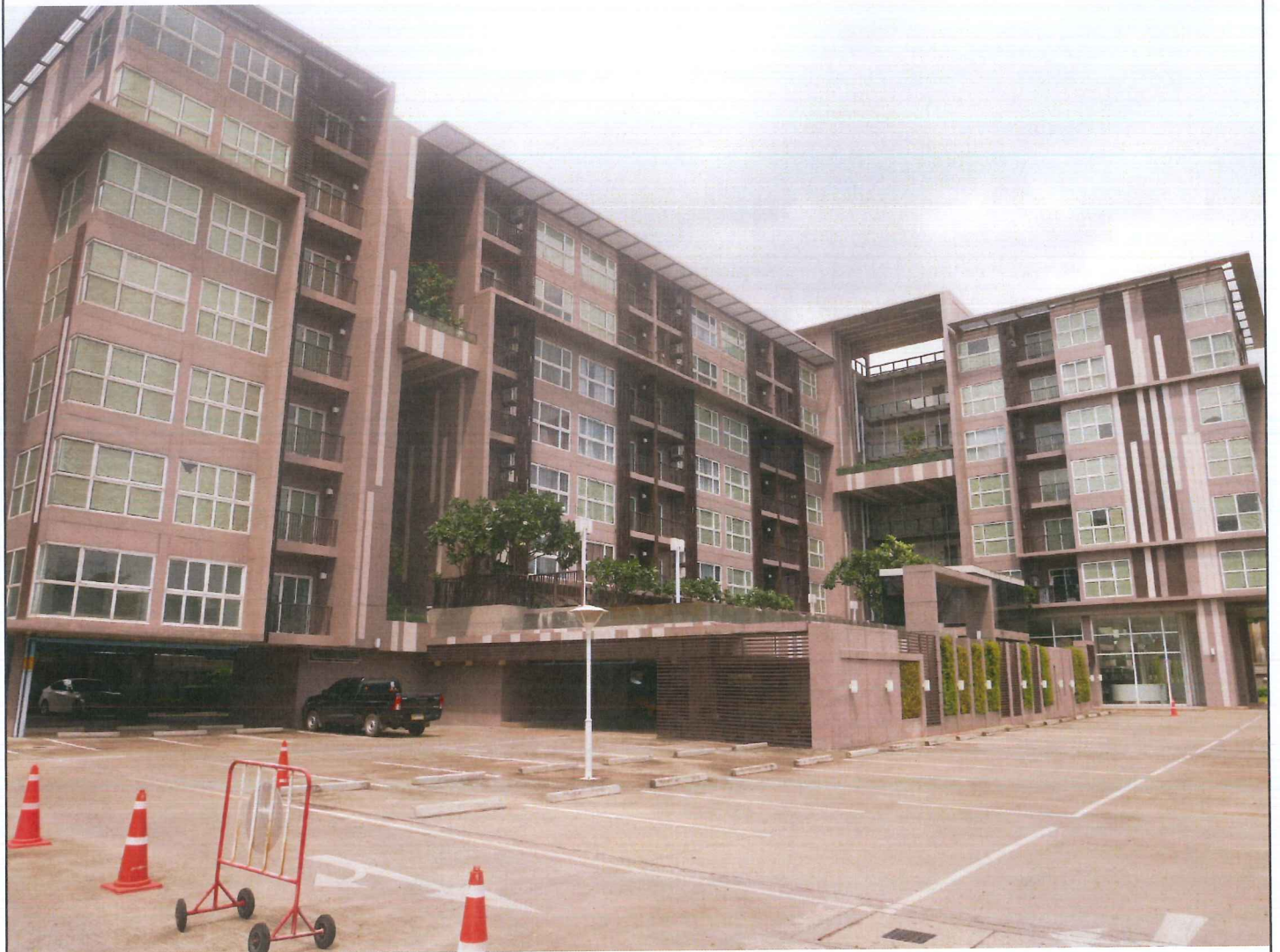
รูปภาพอาคาร ดับเบิลเลค คอนโดมิเนียม เฟส 2 อาคาร 3 ตรวจสอบอาคาร เดือน กรกฎาคม 2562
