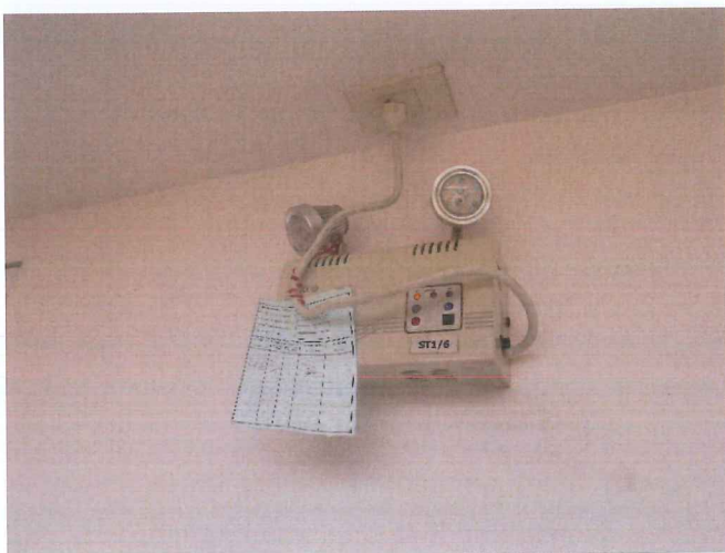
ตัวอย่างไฟส่องสว่างฉุกเฉิน
