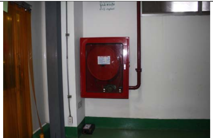
ตู้สายฉีดน้ำดับเพลิง
