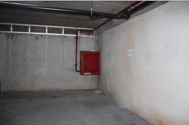
ตู้สายฉีดน้ำดับเพลิง
