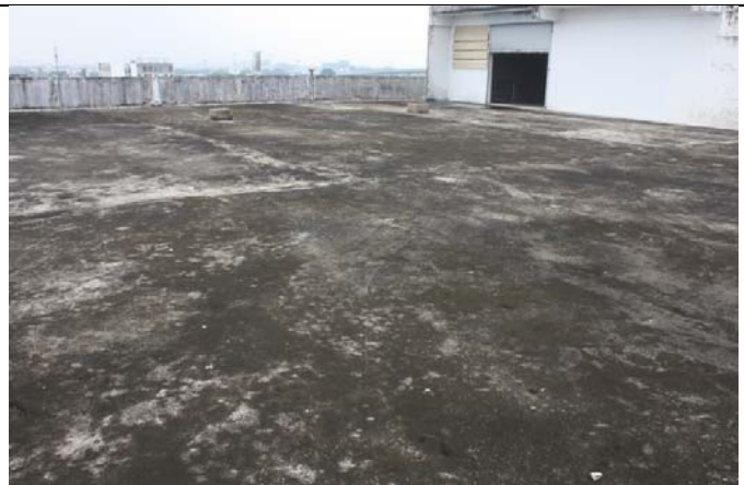
โครงสร้างพื้นดาดฟ้า
