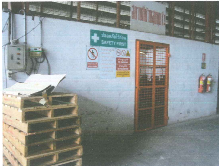
รูปที่ 1.1-05 แสดงภาพสภาพอาคารทั่วไป
