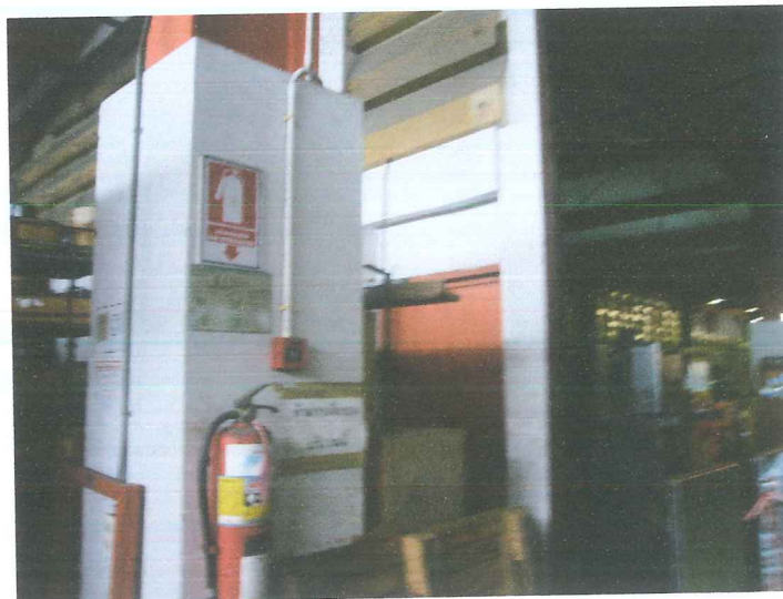
รูปที่ 1.1-09 แสดงภาพสภาพอาคารทั่วไป
