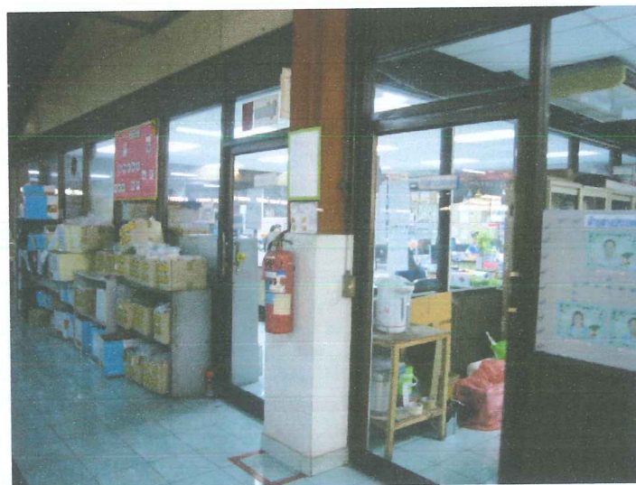
รูปที่ 1.1-12 แสดงภาพสภาพอาคารทั่วไป
