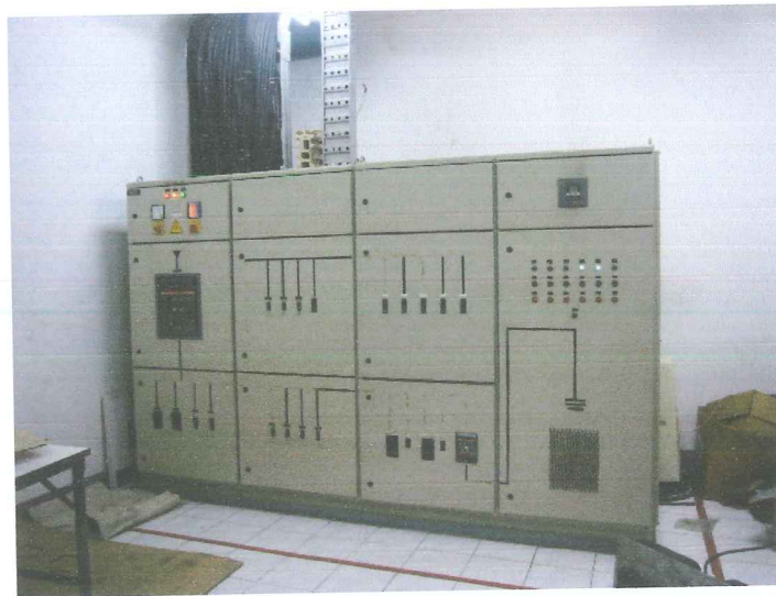
รูปที่ 1.1-08 แสดงภาพสภาพอาคารทั่วไป
