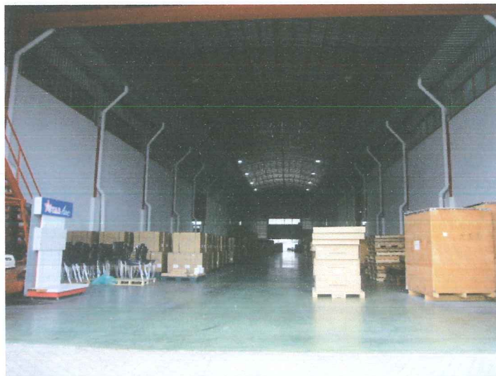
รูปที่ 1.1-04 แสดงภาพสภาพอาคารทั่วไป
