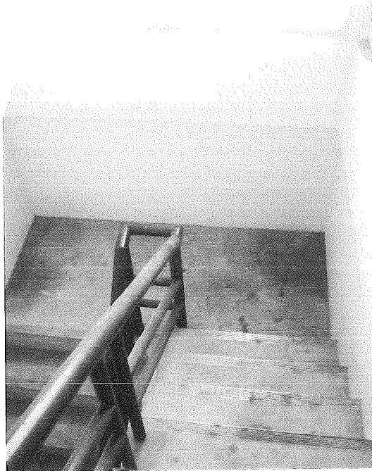
รูปที่ 1.1-15 แสดงภาพสภาพอาคารทั่วไป
