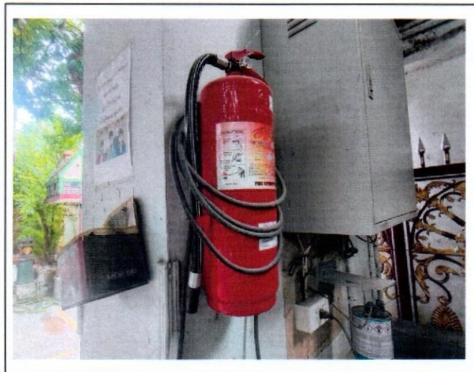
ติดตั้งเครื่องดับเพลิงแบบมือถือชนิดผงเคมีแห้ง
