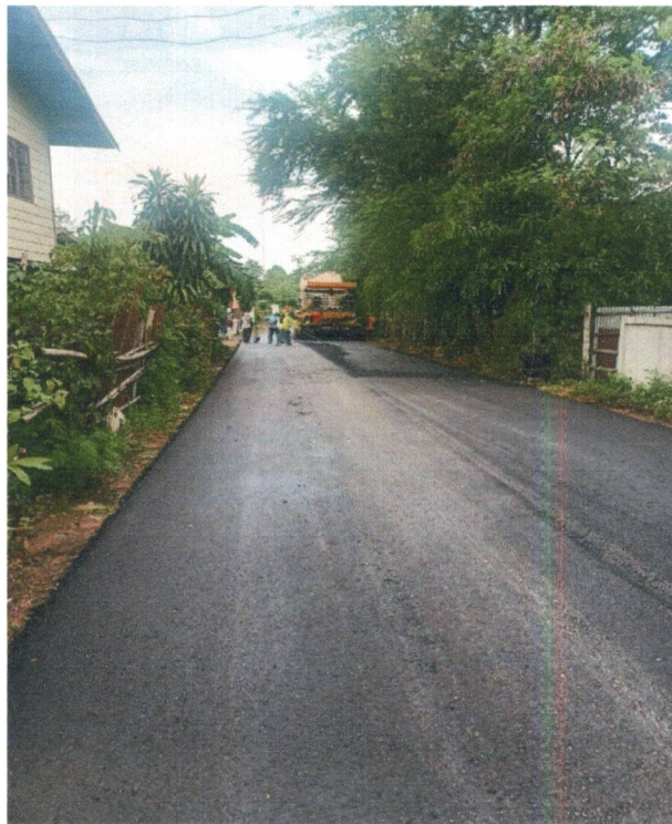
ปรับปรุงผิวจราจรถนน คสล.เป็นแอสฟัลต์ติกคอนกรีต ซอยเทศบาล 21
