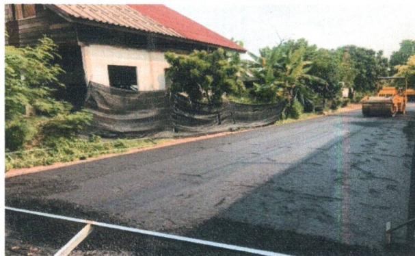
ปรับปรุงผิวจราจรถนน คสล.เป็นแอสฟัลต์ติกคอนกรีต ซอยเทศบาล 21
