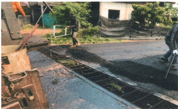
ปรับปรุงผิวจราจรถนน คสล.เป็นแอสฟัลต์ติกคอนกรีต ซอยเทศบาล 21
