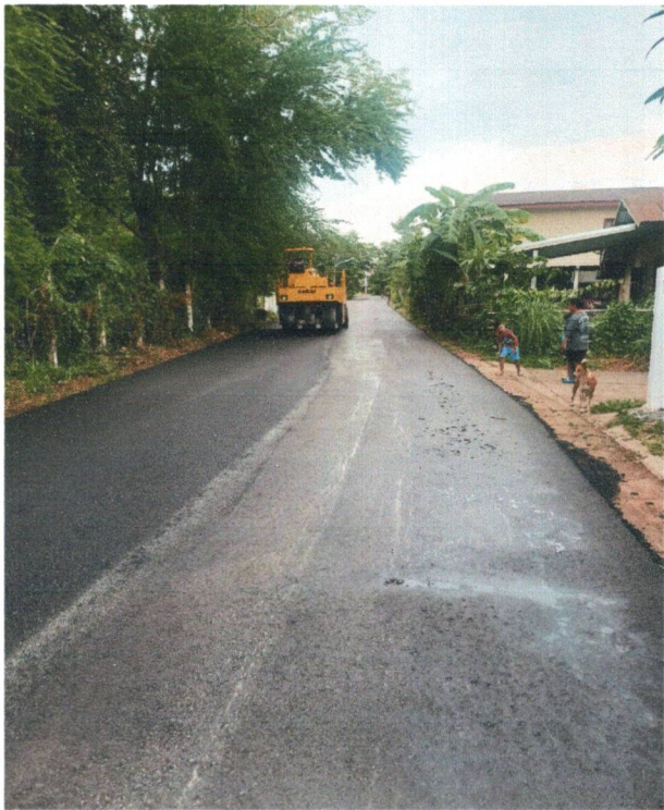
ปรับปรุงผิวจราจรถนน คสล.เป็นแอสฟัลต์ติกคอนกรีต ซอยเทศบาล 21
