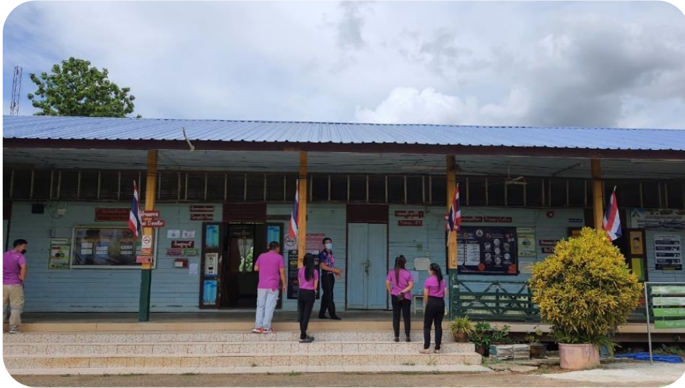
สำรวจอาคารเรียนโรงเรียนบ้านหาดทับยา
