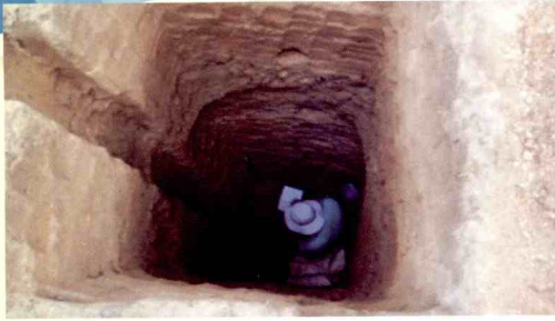
หลุมทดลอง เพื่อเก็บตัวอย่างบริเวณผนังของหลุมทดลอง และศึกษาลักษณะการเปลี่ยนแปลงของชั้นหินแกรนิต
