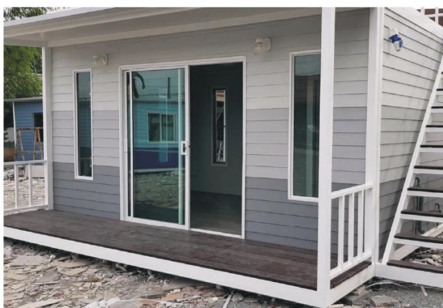
บ้านประกอบเสร็จ
