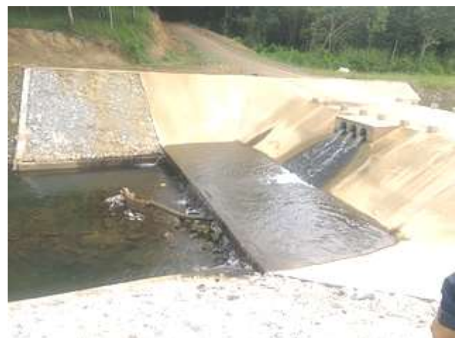
๓. ก่อสร้างฝายน้ำล้นคอนกรีตเสริมเหล็ก บ้านคลองเพลิ้นแบบน้ำล้นผ่าน ม.๙ ต.ร่อนทอง อ.บางสะพาน งบประมาณ ๑,๑๔๕,๕๐๐ บาท
