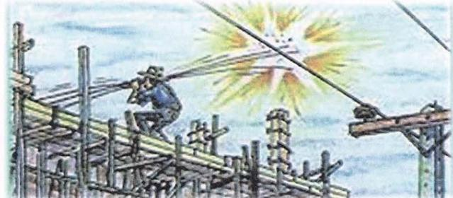
๗. การก่อสร้างตึก อาคารในบริเวณที่ใกล้แหล่งไฟฟ้าแรงสูง ผู้ปฏิบัติงานต้องระมัดระวังอย่าให้วัสดุก่อสร้างไป接触สายไฟฟ้าแรงสูง และผู้ดำเนินการก่อสร้างควรติดต่อการไฟฟ้าส่วนภูมิภาคในท้องถิ่นเพื่อทำการครอบฉนวนที่สายไฟฟ้าแรงสูงให้ซึ่งจะช่วยให้ปลอดภัยในการปฏิบัติงาน
