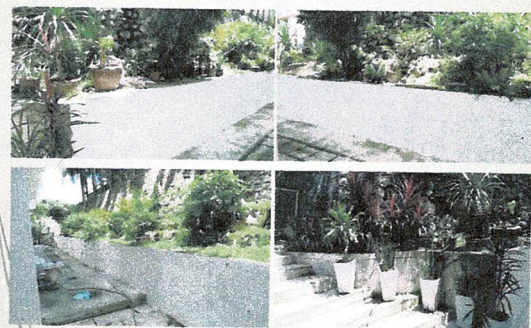
โครงการก่อสร้างกำแพงกั้นดินโรงเรียนเทศบาล ๑ (บ้านเขาแก้ว)
