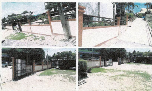
โครงการก่อสร้างรั้วโรงเรียนเทศบาล ๑ (บ้านเขาแก้ว)
