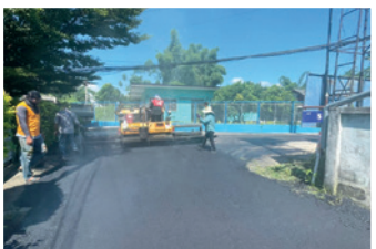
โครงการเสริมผิวถนนด้วยแอสฟัลต์ติกคอนกรีตด้วย Over Lay ซอยบ้านดอนแก้ววิลเลจ 1 หมู่ที่ 1
