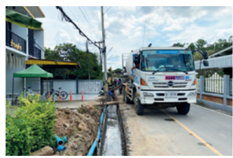
โครงการก่อสร้างรางระบายน้ำ ค.ส.ล.และวางท่อระบายน้ำ ค.ส.ล.ถนนสายหลักหมู่ที่ 2 บ้านดอนแก้ว
