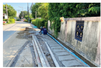
โครงการก่อสร้างรางระบายน้ำ ค.ส.ล.และวางท่อระบายน้ำ ค.ส.ล.ถนนสายหลักหมู่ที่ 2 บ้านดอนแก้ว
