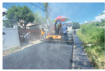
โครงการเสริมผิวถนนด้วยแอสฟัลต์ติกคอนกรีต Over lay ถนน สายหลักบ้านป่ารวกเขตติดต่อบ้านพระนอน หอพักไวทโรส
