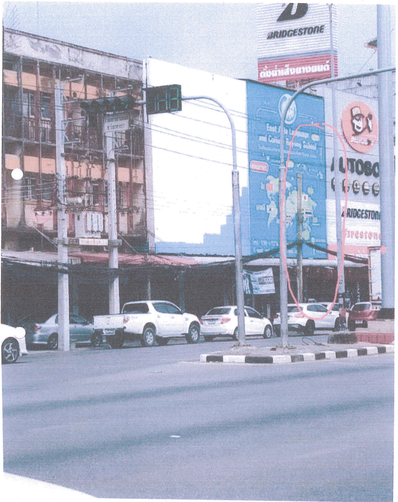
ได้ทำการติดตั้งเสาคอนกรีตเพิ่ม จำนวน ๑ ต้น
