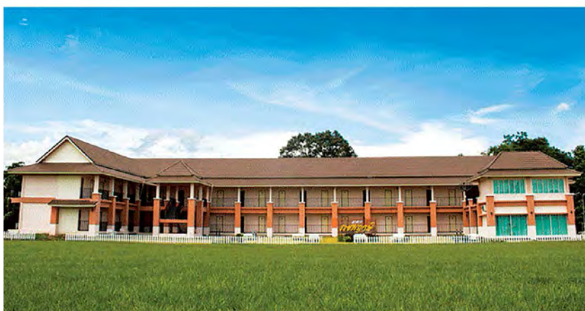
อาคารที่พักสำหรับผู้เข้าอบรมและบุคคลภายนอก
