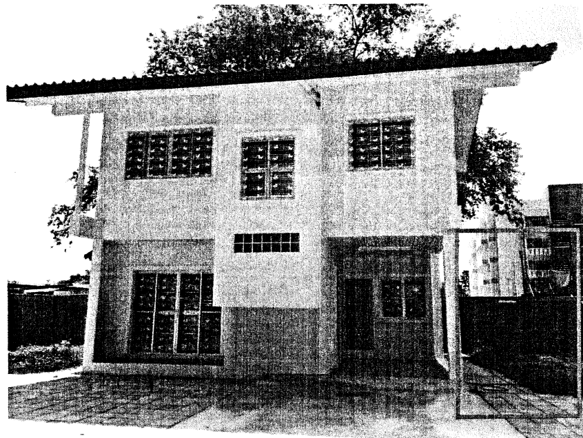
บ้านพักเลขที่ ๓๔๒ ต่อเติมโรงจอดรถบริเวณข้างบ้านพัก (กรอบสีแดง)
