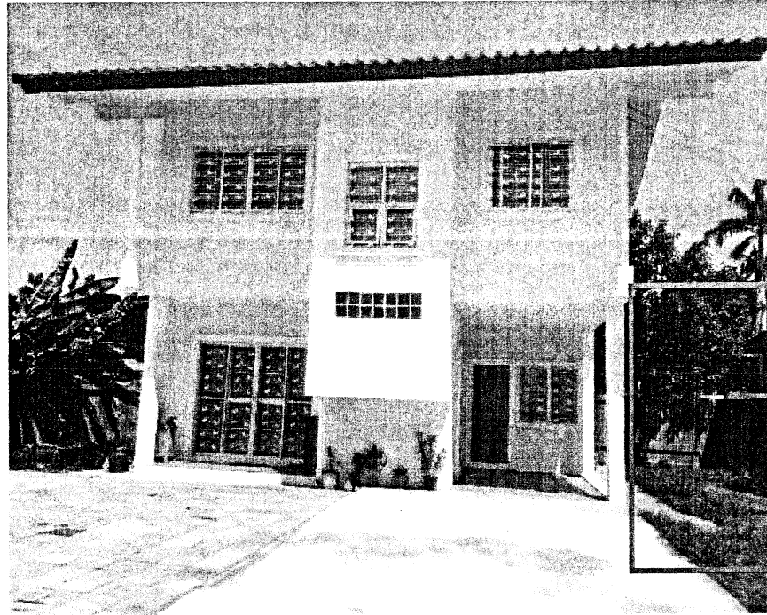
บ้านพักเลขที่ ๔๐๖ ต่อเติมโรงจอดรถบริเวณข้างบ้านพัก (กรอบสีแดง)
