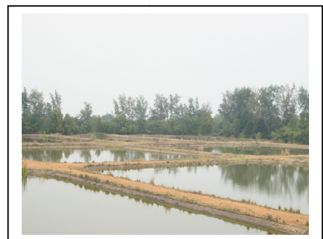
ระบบบำบัดน้ำเสียแบบบ่อผึ่ง
