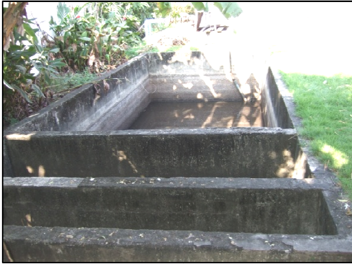
บ่อดักไขมันและขยะ ของน้ำทิ้ง ก่อนเข้าสู่บ่อกลวงวนเวียน
