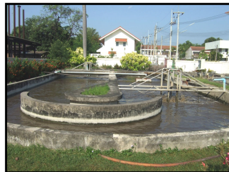
กลวงวนเวียน เป็นการเติมออกซิเจนในน้ำโดยใช้เครื่องตีน้ำ
