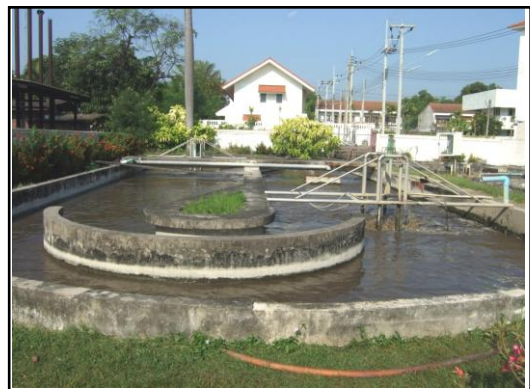
คลองวนเวียน เป็นการเติมออกซิเจนในน้ำโดยใช้เครื่องตีน้ำ
