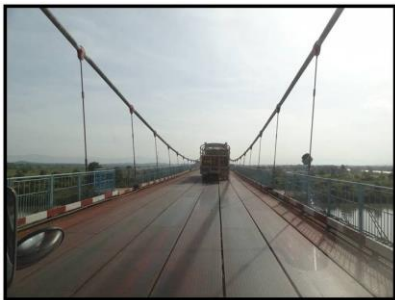
สะพานจิงเน่ (Jine bridge)
